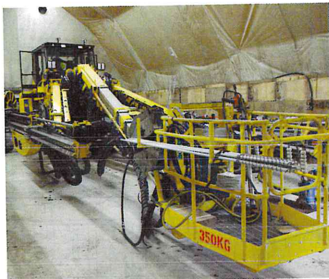
Tre slike borerigger til 20 millioner kroner hver benyttes i tunneldrivingen.
