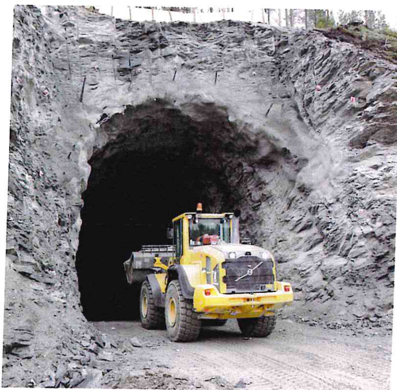
Arbeidet med tilførseltunnelen, eller tverrslaget i Kåsdalen har kommet godt i gang.
