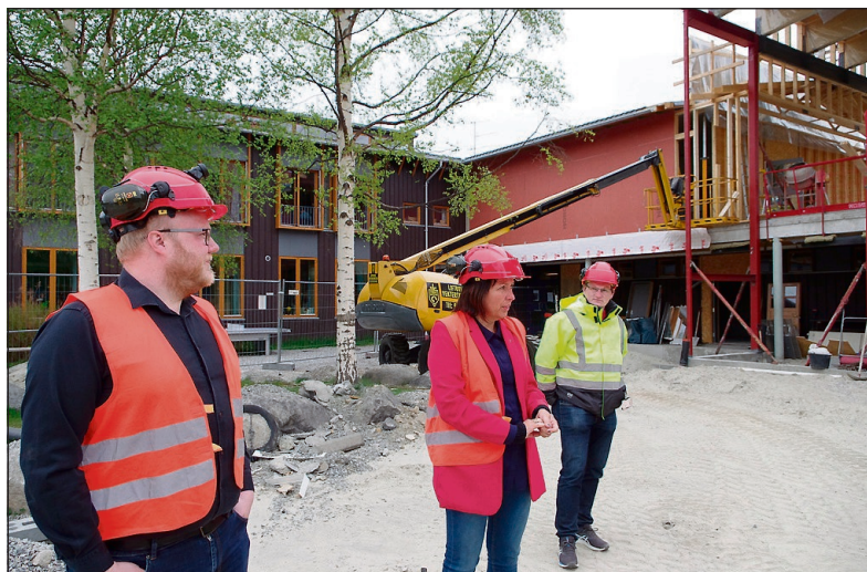
BINDER SAMMEN: Skolen til venstre og nybygget til høyre bindes sammen av nytt skolekjøkken, bak den rødlige veggen. Ordfører Bjørnar Tollan Jordet (t.v.), rådmann Siv Stuedal Sjøvold og prosjektleder Jon Arve Engebakken tok Retten med på en rundtur på byggeplassen. (Foto: Tonje Hovensjø Løkken)
