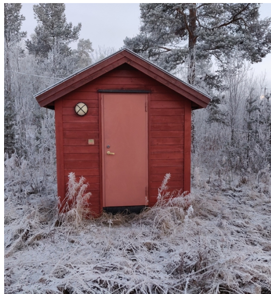
Figur 23 Standard type overbygg for vannpumpestasjoner
