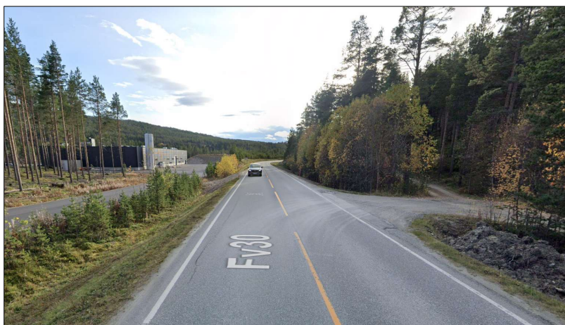
Figur 2.7.4: Avkjørsel fra fv. 30 til områdene på vestsiden, sett fra nord (Kilde: Google street view, 10/2023).
