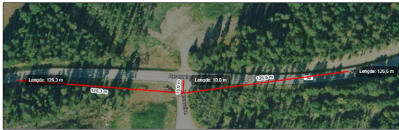
Figur 5.5.7: Ortofoto fra avkjøringen med siktlinjene markert i rødt.
