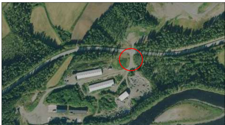
Figur 5.5.6: Ortofoto fra 2024 viser den aktuelle avkjøringen ved Kåsbekken markert med rød ring.
