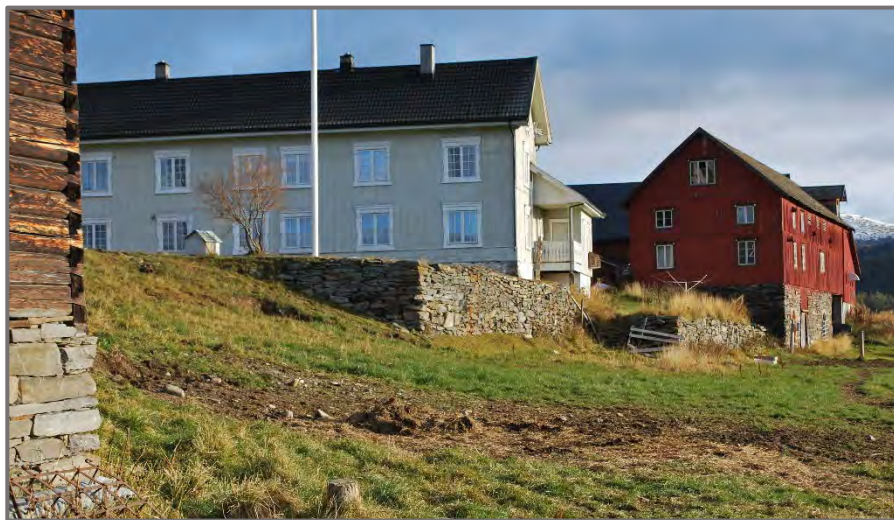
Figur 8.7: Murene utgjør viktige oppbygninger og forstøtninger av terrenget som bebyggelsen står oppå, og er også ofte en del av bygningskonstruksjoner. Bildet viser Lensmannsgarden i Erlia. Helt til venstre i bildet sees Lensmannsarresten (objekt 83). Foto høst 2019: Anja Ø. Ryen
