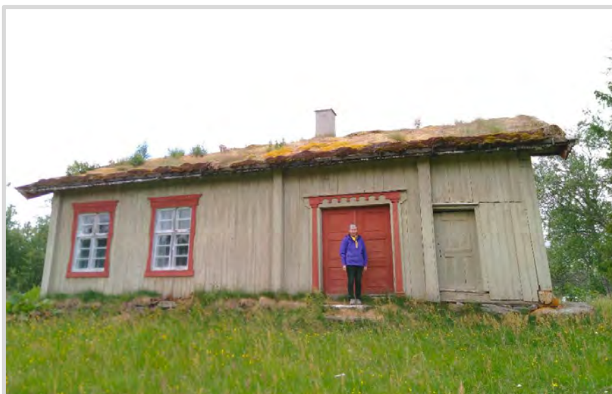
Figur 10.8: Som skolestue er gammelskola fra 1858 et viktig element i kulturmiljøet i Øversjødalen. Foto: Ingebjørg Øveraasen/Bygningsvernhuset AS
