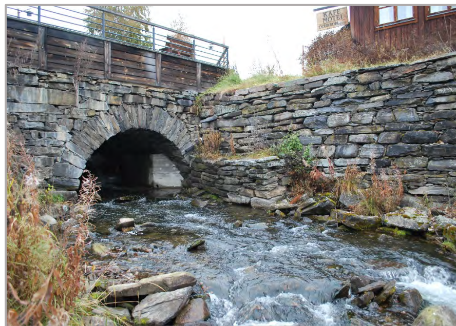
Figur 9.7: Under det som i dag er Fv30, ligger en langt eldre hvelvbru over elva Tolja. Foto: Anja Ø. Ryen
