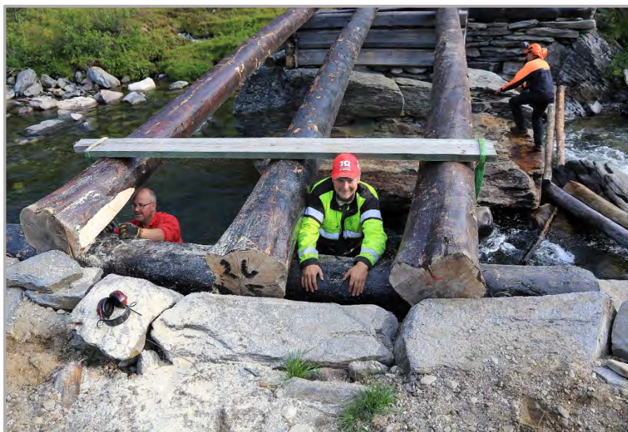
Figur 9.6: Bilde fra restaureringsarbeidet 2018. Embret Rønning, Rune Westberg og Ragnar Sollid. Foto: Stein Kaasin.
