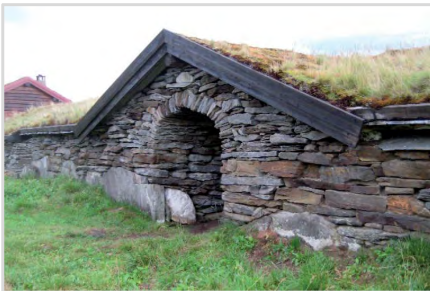
Figur 7.16: Steinfjøset på Evensmovangen. Foto: Per Hvamstad
