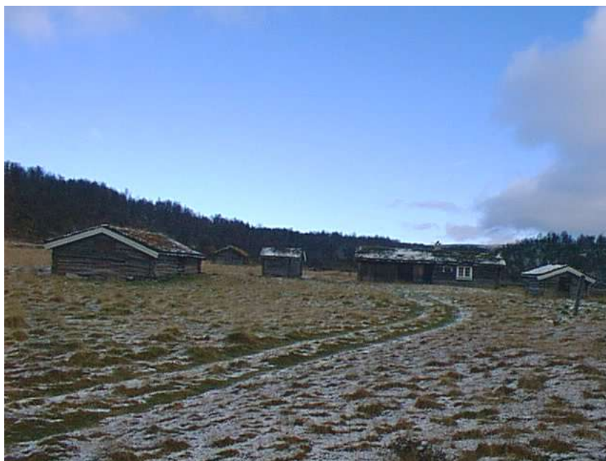
Storøyvollen med restaurert seterfjøs
